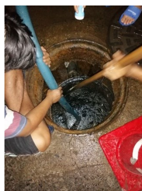
การสูบน้ำจากระบบบำบัดน้ำเสีย
